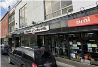
Figure 39 : EXEMPLE D'INTÉGRATION D'UN COMMERCIAL AU REZ-DE-CHAUSSEE AU SEIN D'UN BÂTIMENT MIXTE, SAINT-COLOMBAN (SOURCE PHOTO: GÉOBLA)
